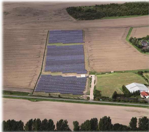
Solarpark Herbsleben, Inbetriebnahme: 2010
