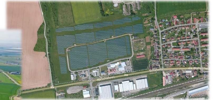
Solarpark Roßla, Inbetriebnahme: 2010
