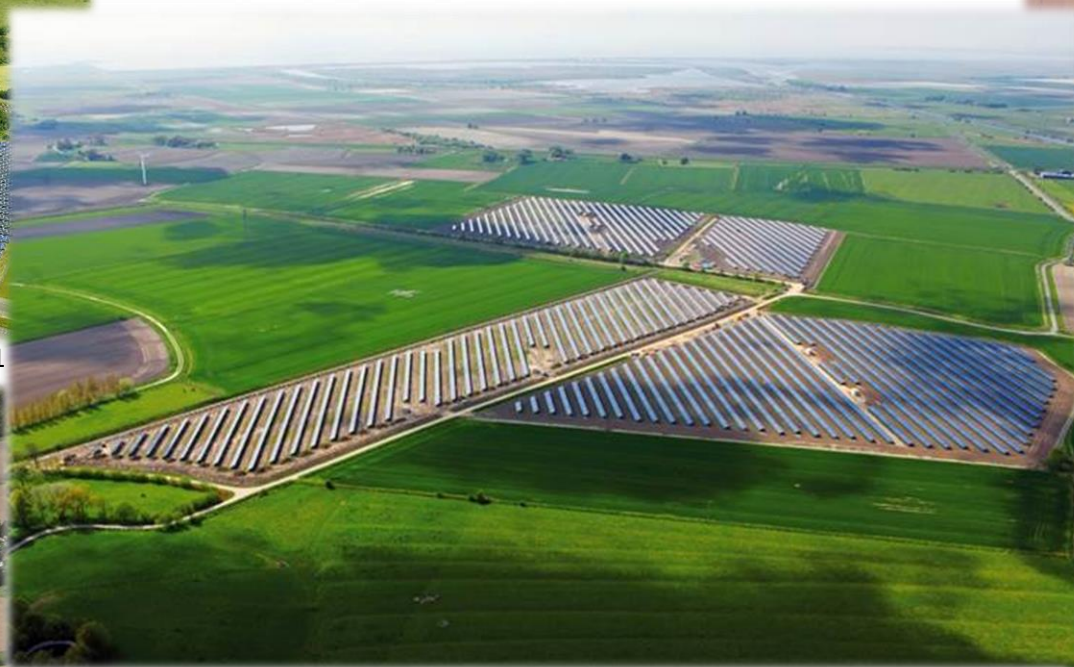
Solarpark Meldorf, Inbetriebnahme: 2010
