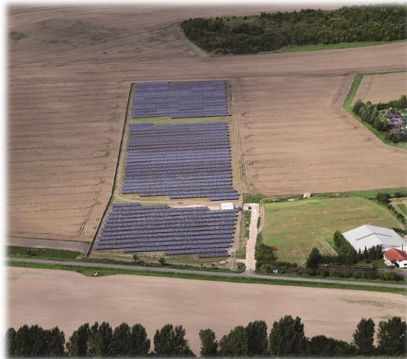
Solarpark Herbsleben, Inbetriebnahme: 2010
