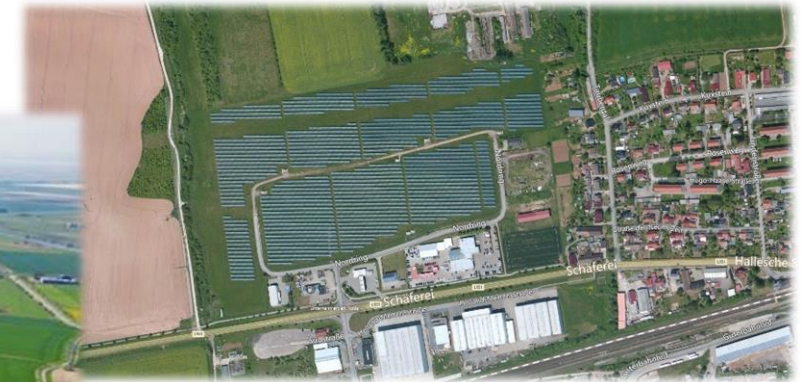
Solarpark Roßla, Inbetriebnahme: 2010
