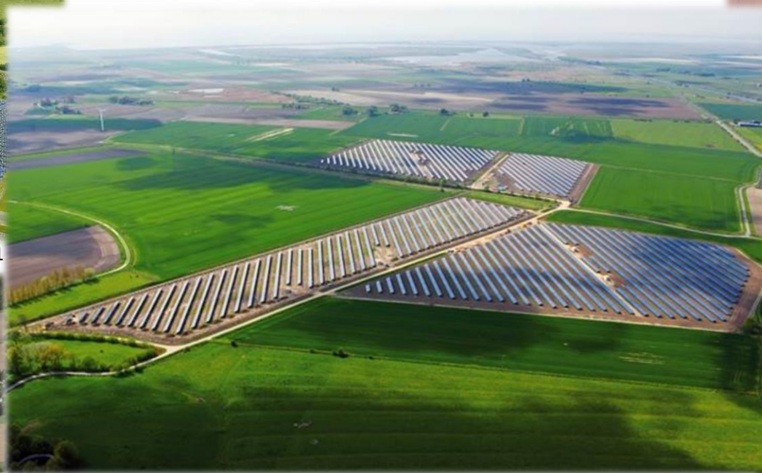
Solarpark Meldorf, Inbetriebnahme: 2010
