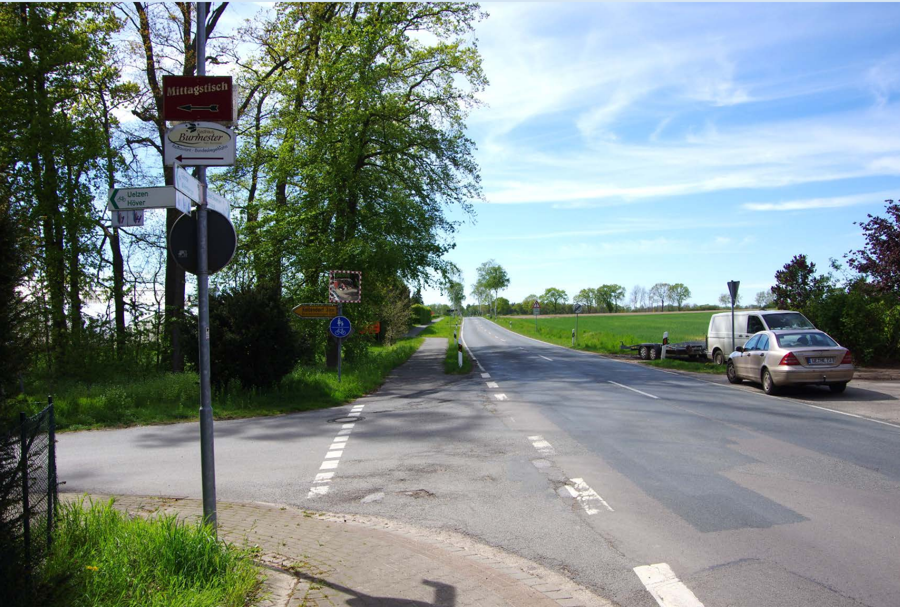
Ortseinfahrt im Zuge der L 253 in Almstorf
