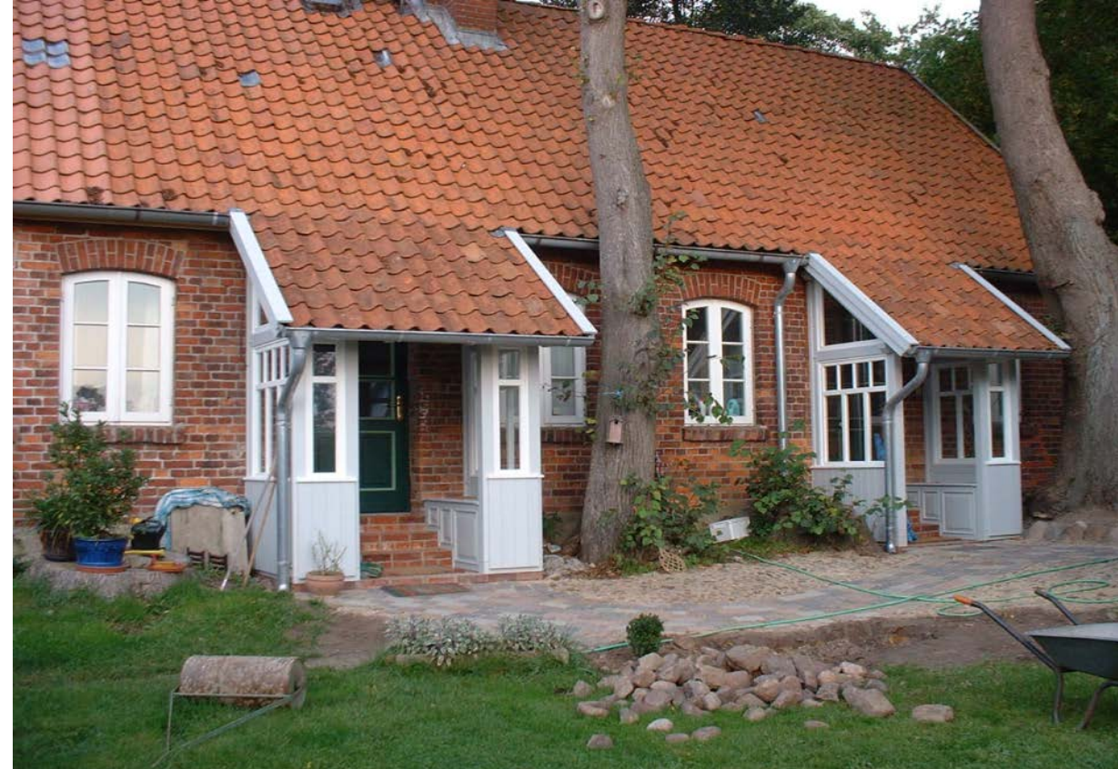
Erneuerung der Türen und der Vorbauten in Luttmissen
